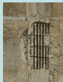
Sgretolamento del calcestruzzo copriferro e ossidazione del ferro di armatura.
